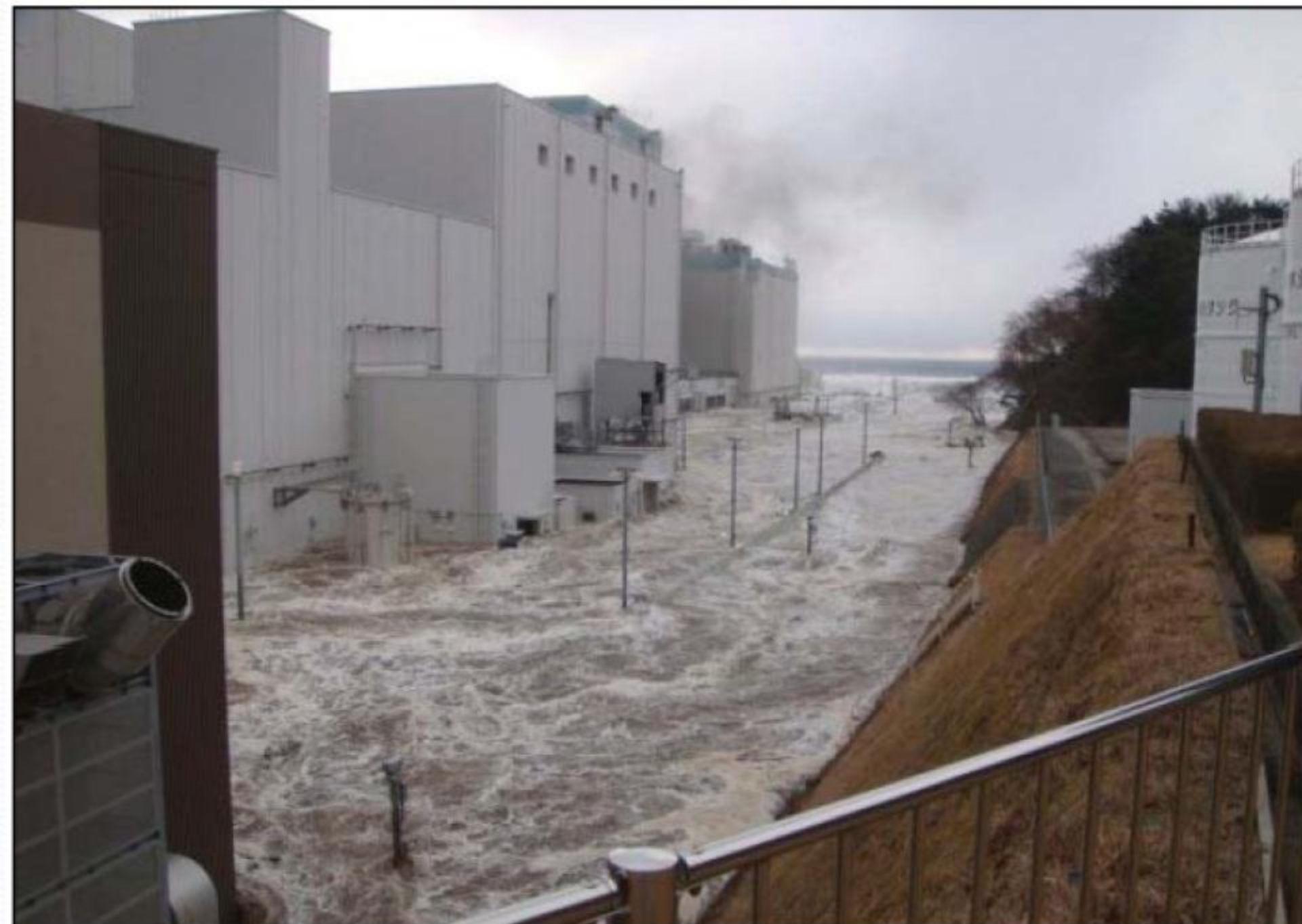
Inundación de 2 a 3 m junto al edificio del reactor 1
