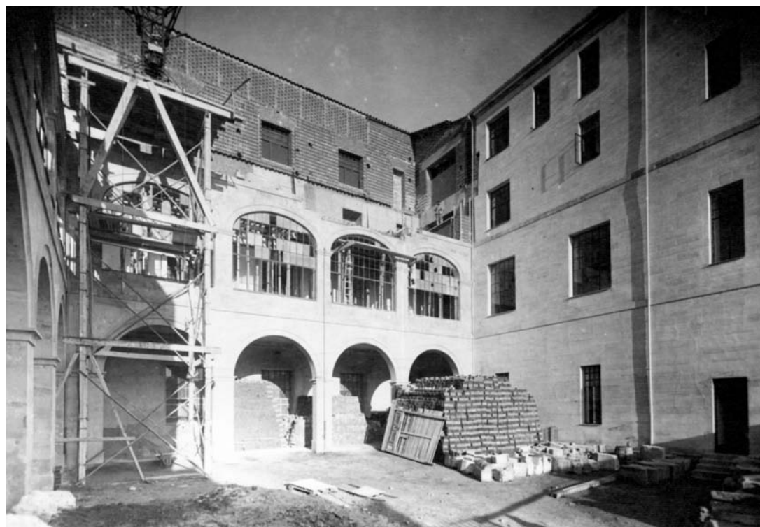
2.6. Obras de remodelación y ampliación del centro. F: AUSA.
