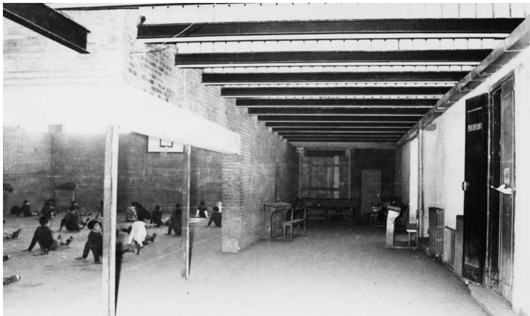
2.26. El precario gimnasio del centro en 1968. F: AUSA.
