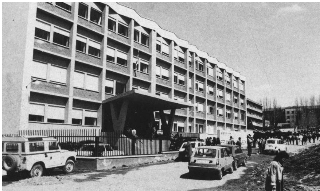
4.1. Fachada principal del Instituto a mediados de los 80. Terraplenes y barro.
