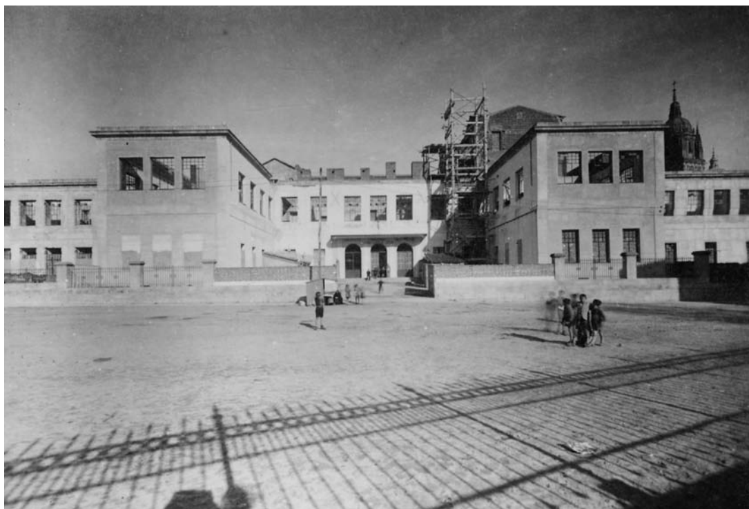
2.2. Fachada principal del instituto nacional de enseñanza media en el Trilingüe durante los años cuarenta. F: AUSA.
