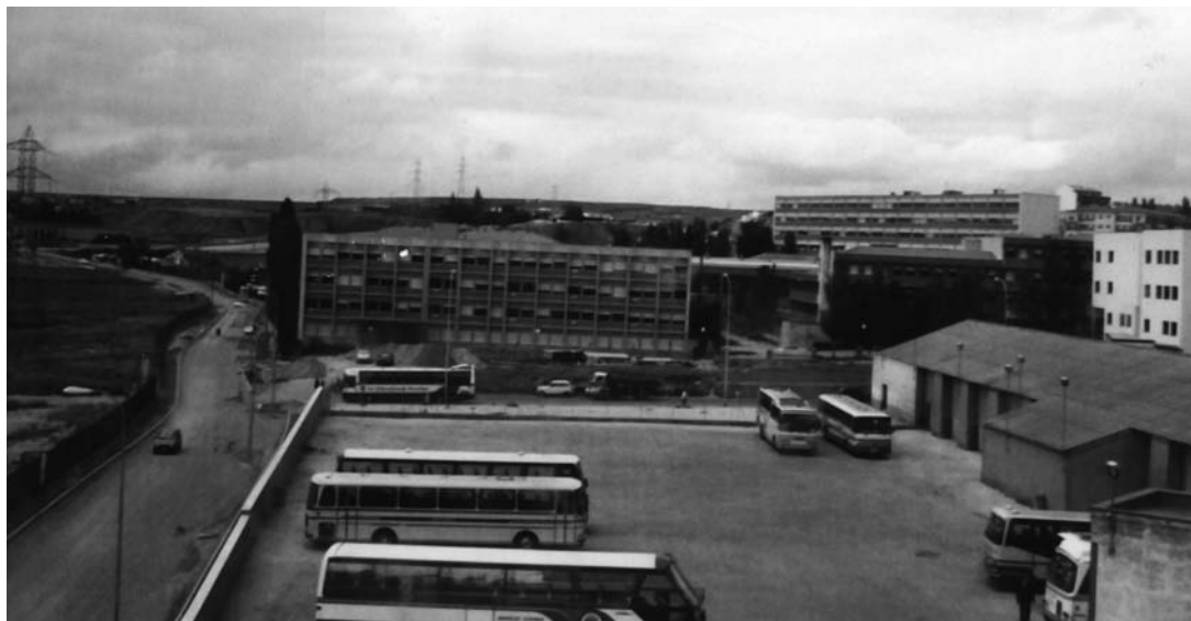
3.21. Vista del Instituto Fray Luis de León desde las viviendas aledañas a la estación de autobuses. F: Fátima Calvo.
