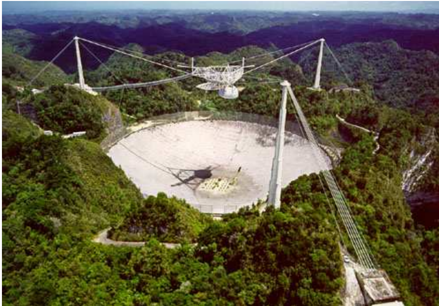
Radio telescopio de Arecibo en Puerto Rico, de 300m de diámetro.
